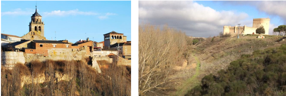
Fig. 22. Derrumbamiento (izquierda) y ladera arcillosa (derecha) en el Arevalillo. Autor: Francisco Durán.
